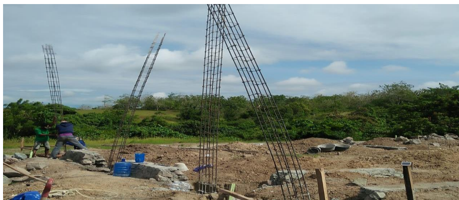
Gambar 1: Proses pembangunan gedung pesantren
